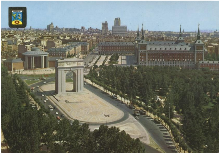
Figura 11. Vista general de la Plaza de la Moncloa en una postal turística de los años sesenta. Podemos observar el edificio del Ministerio del Aire (derecha), el conjunto de viviendas militares que se sitúan en torno a la gran lonja abierta a la calle de la Princesa y, situado en el mismo eje que el Arco de la Victoria, el Monumento a los Caídos de Madrid (izquierda).
