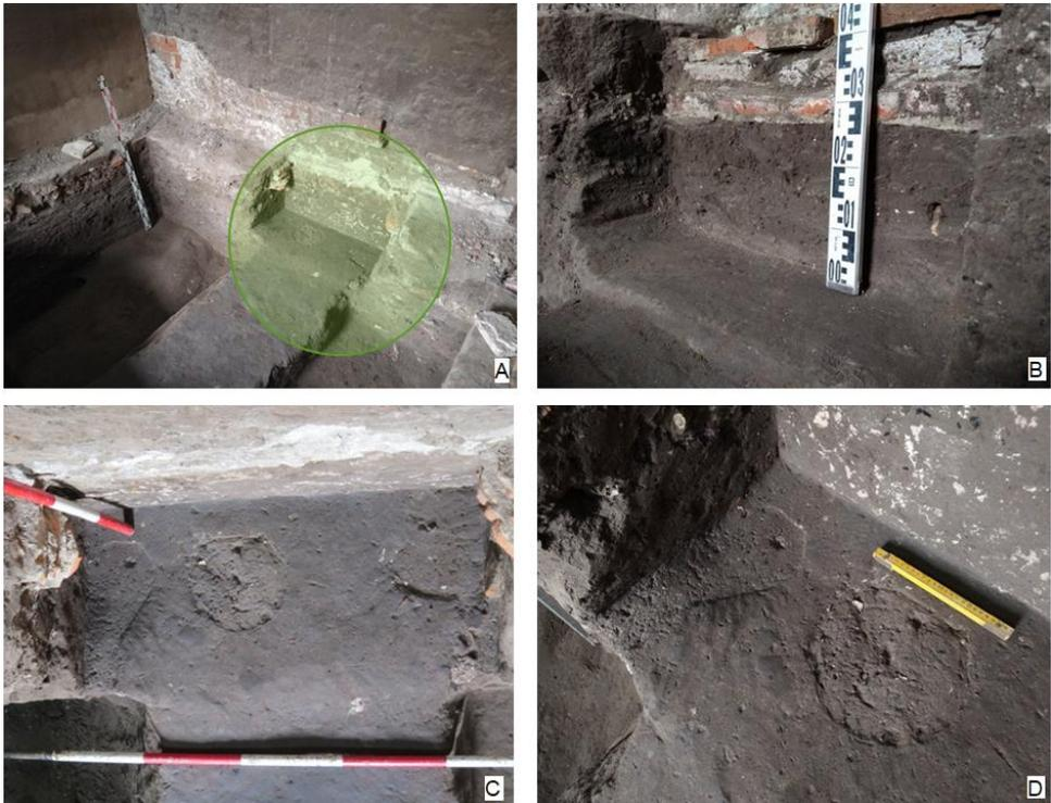
Figura10. Superficie apisonada (A y B) donde se identificaron huellas de los postes (C y D) que sostenían el encofrado con el que se construyó la pared de tapia. Fuente: Museo Etnográfico y Colonial.
