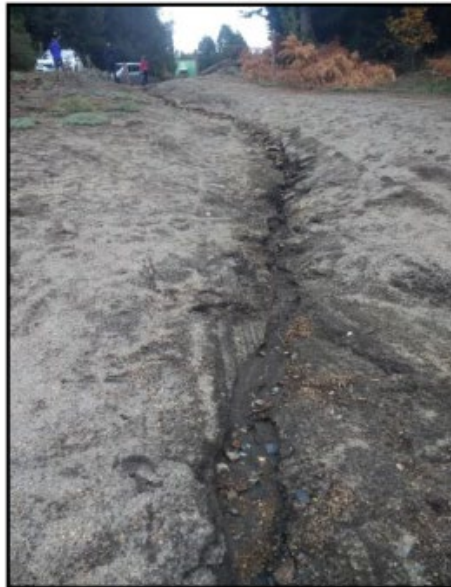
Figura 2. Evidencias de erosión hídrica.
