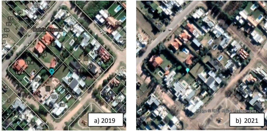
Figura 9. Detalle de construcciones sobre zona de servidumbre en Mz 184j.
