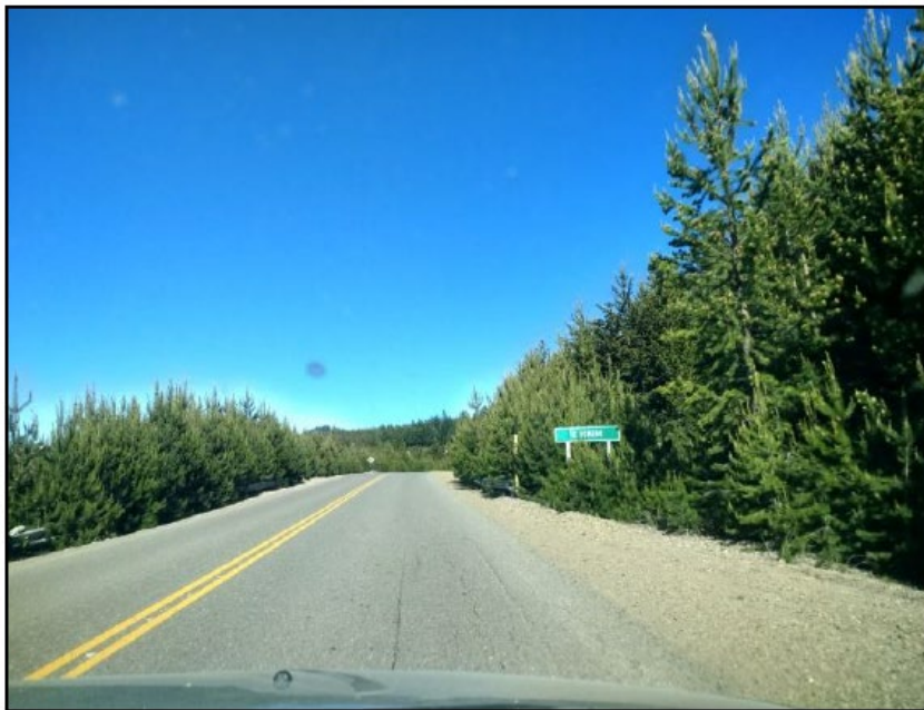
Figura 6. Pinos que sobrepasan las barandas de seguridad vial y tapan la cartelería
