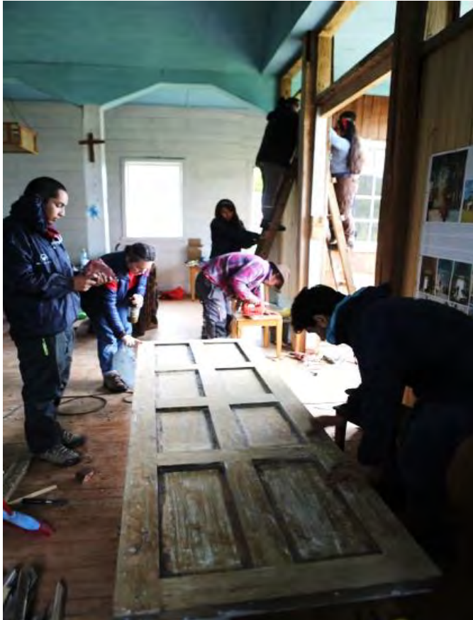
Imagen 11.- Instalación de ventanal central del pórtico, 2018. Fuente: María Peña.
