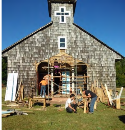
Imagen 6.- Construcción del nuevo pórtico, 2016, fuente: Cristina Ciudad.
