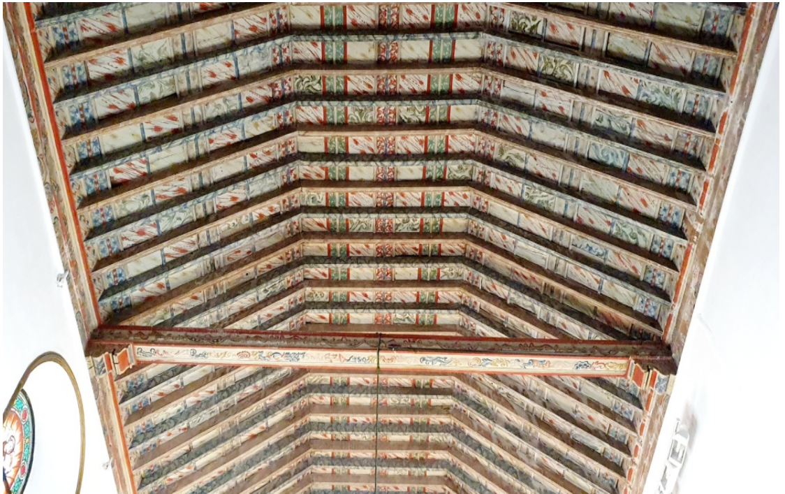
Fig. 9. Techumbre de la nave central, Juan Hernández Delgado (1750), Iglesia de la Venerable Orden Tercera de San Francisco, Santa Cruz de Tenerife (Islas Canarias, España). Fuente: fotog. del autor.
