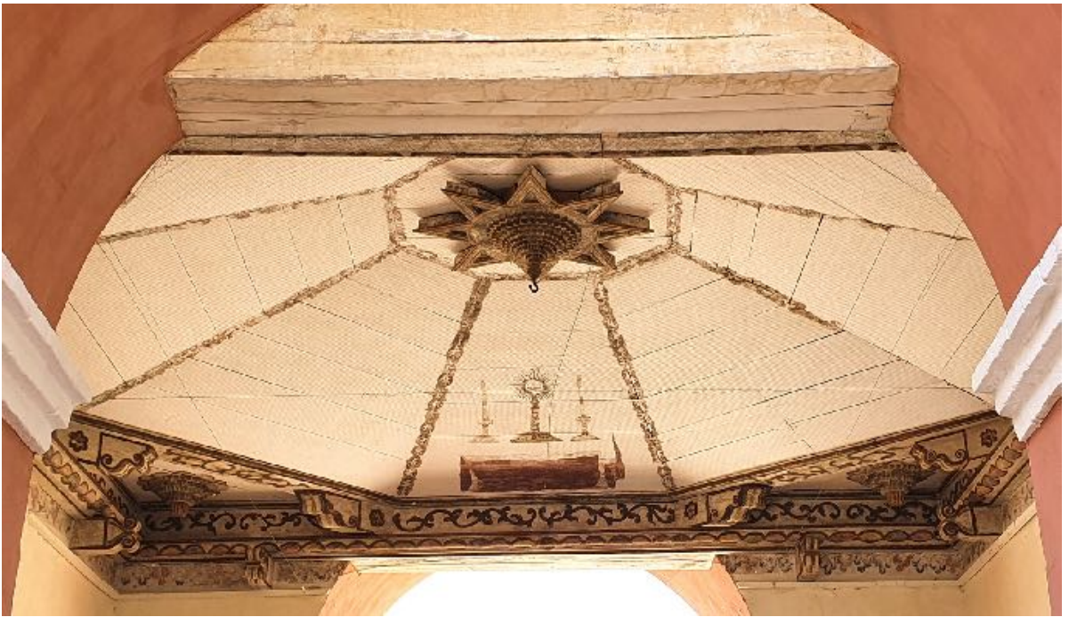
Fig. 6. Techumbre del nivel inferior de la puerta del Carmen, 1677, San Cristóbal de Las Casas, Chiapas (México). Fuente: fotog. del autor.
