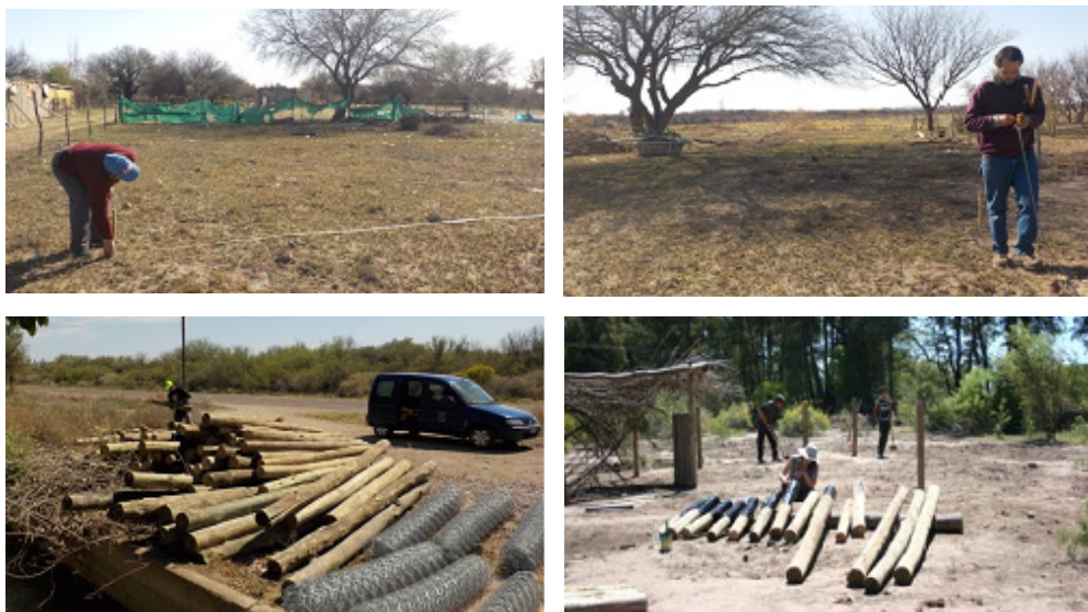
Figura 8. Medición y demarcación de huertas (arriba); armado de la estructura de rollizos (abajo)
