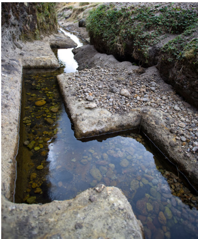
Figura 1. El canal Cumbemayo. Tramo de canal en piedra
