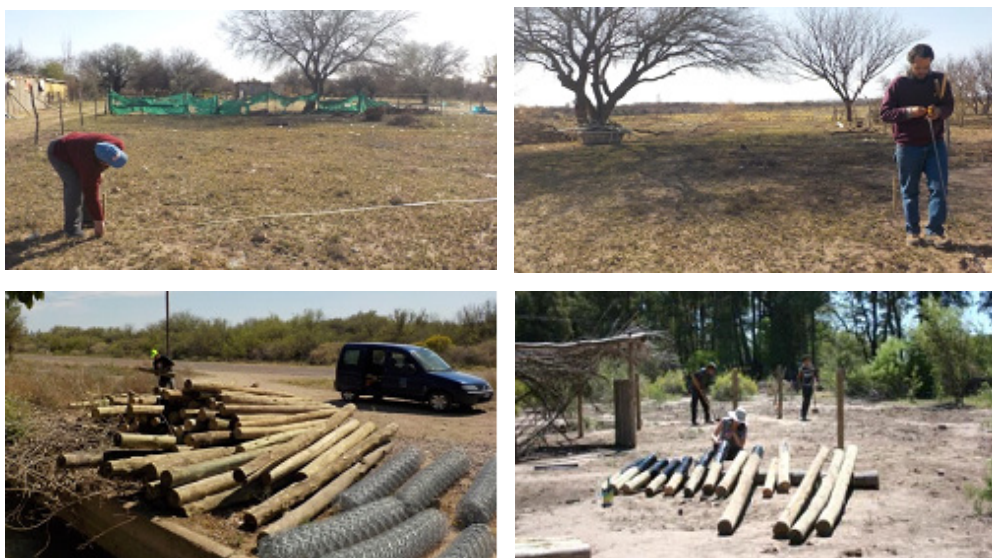
Figura 8. Medición y demarcación de huertas (arriba); armado de la estructura de rollizos (abajo)
