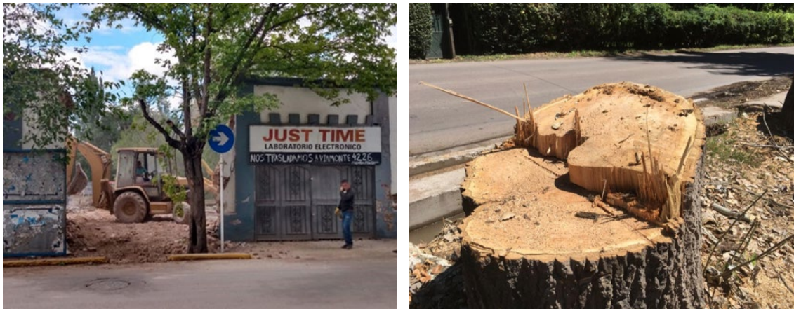
Fig. N° 2 y 3. Demolición de casas del centro histórico y tala de árboles centenarios en calle Darragueira.
