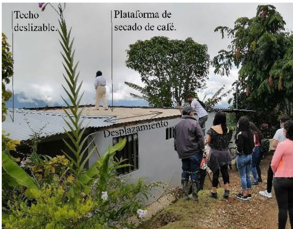
Fig.N°3. Vivienda con techo deslizable para secado del café, UAF 01, Caparrapí
