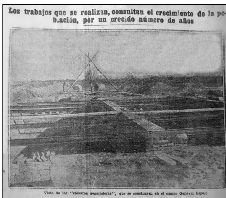
Figura 6: Trabajos de la red cloacal. Mendoza-1924
