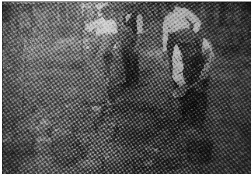
Figura 8: Calzada hundida por errores técnicos en la construcción de la red cloacal
