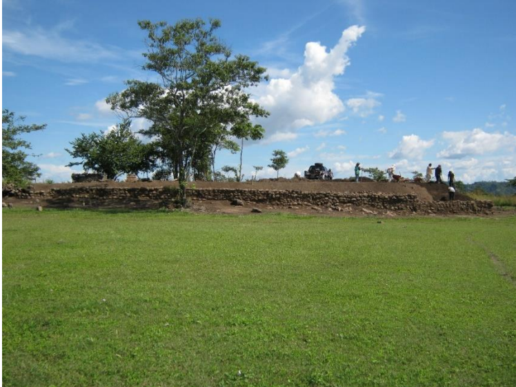
Figura 7. Estructura 4E2, esquina sureste de la plaza mayor, después de la consolidación parcial y restauración de los lados oeste y sur (en el extremo derecho), 3 de noviembre de 2011. Vista hacia el este. Fuente: Fotografía cortesía de Hugo Iván Chávez. Proyecto Arqueológico Ciudad Vieja. 2022:100-107). En esta ubicación se presenta la Estructura 4G1, un complejo arquitectónico angosto, alargado y en forma de montículo que, visto en planta, se asemeja a la planta de una iglesia medieval española de una sola nave o de una capilla abierta mexicana (Figuras 2, 3, 8 y 9) (Kubler, 1948:2: 232-240; 2012: 290-298; Lara 2004: 17-36).
