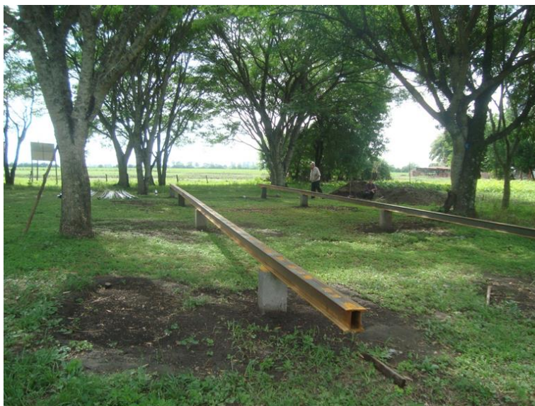
Figura 9: Instalación de bases y perfiles doble T. Fotografía del autor.
