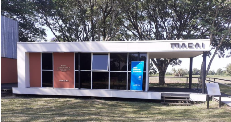
Figura 17: Módulo de Información actualmente. Fuente: foto Archivo Dirección de Patrimonio.
