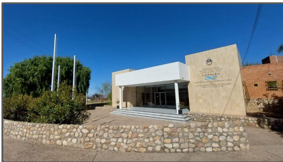
Figura 2. Edificio del CRILaR. Fotografía tomada desde el noroeste, en la que se aprecia la explanada y el ingreso principal. (Original para este artículo).
