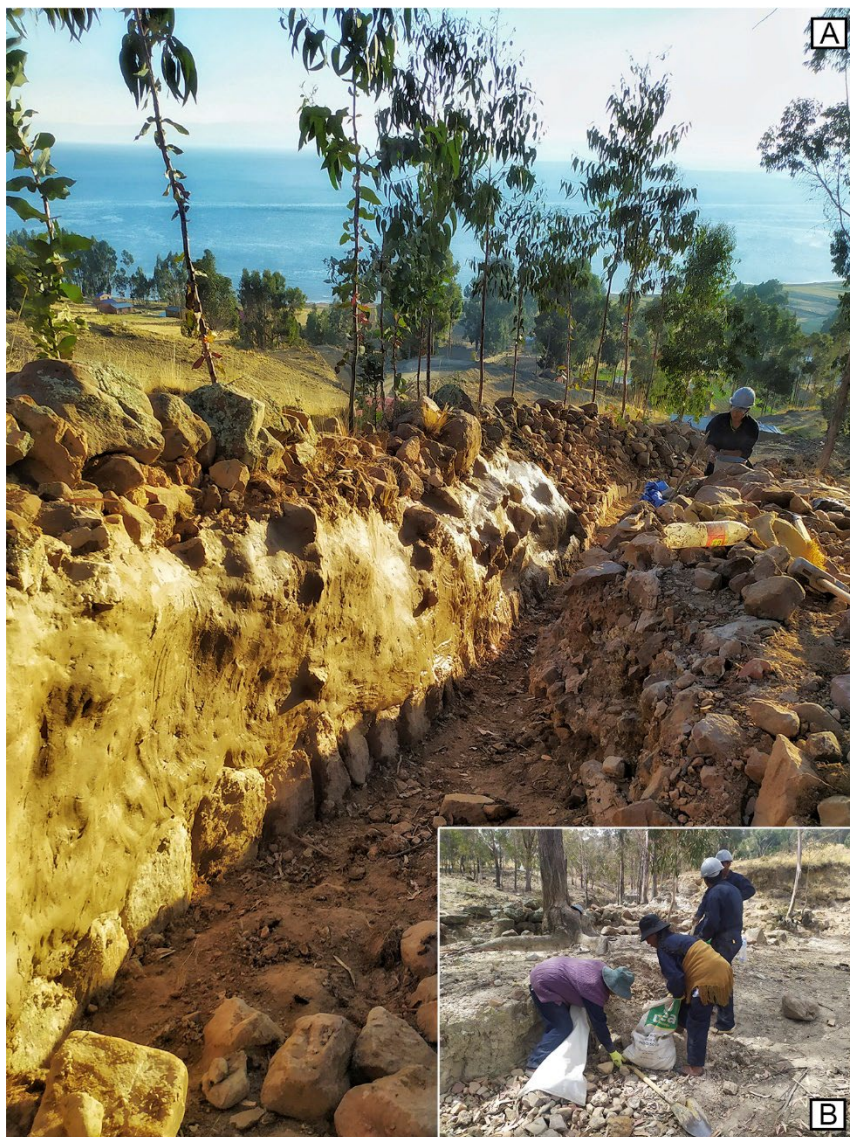
Figura 5. A: Impermeabilización de muros de contención con greda local. B: Recolección de greda por parte de los pobladores locales. Fotografías del Proyecto.
