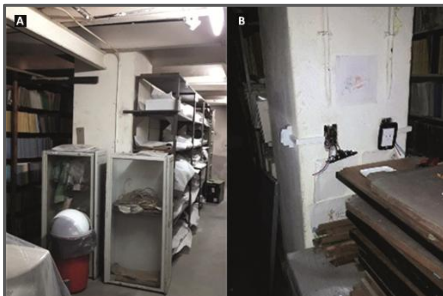
Figura 4. Espacio de guardado de las reservas técnicas del Museo de La Plata. A. Falta de aislamiento. Espacio compartido con el depósito de la biblioteca. B. Instalación eléctrica deficiente. Fuente: elaborada por M.M. Reca y V. Melemenis.
