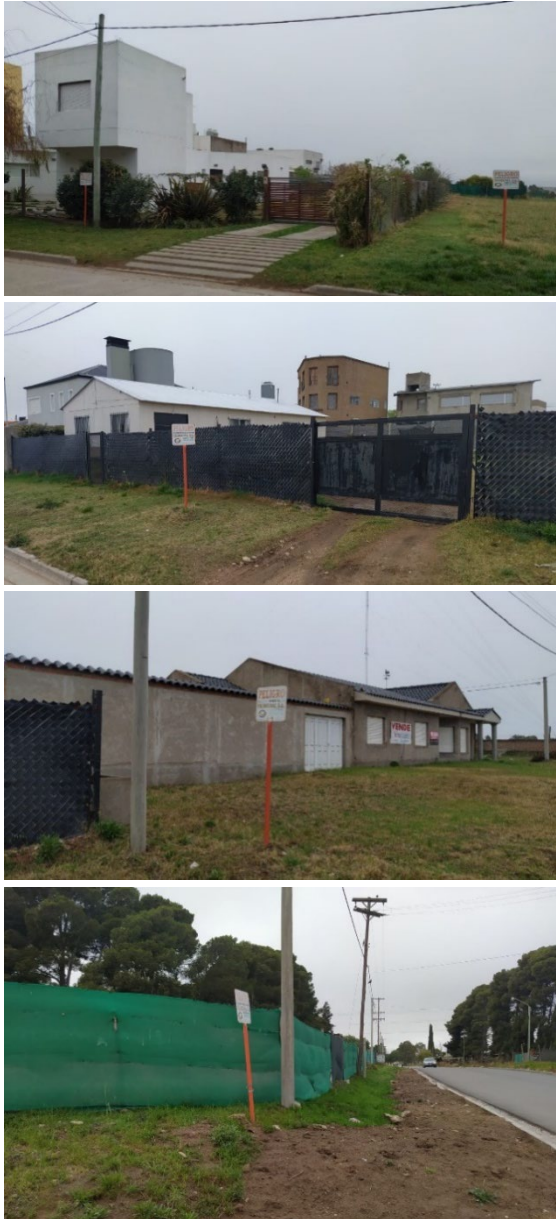
Figura 7 (a,b,c y d.) . Cartelería de advertencia por presencia de ducto. Construcciones y arbolado sobre zona con restricciones. Fuente: Elaboración propia (Agosto de 2021)
