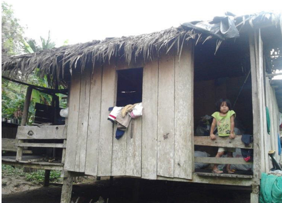
Figura 4. Franco, Angélica. (2012). Casa tradicional indígena elaborada con madera de chonta y techo de paja. Recuperado de http://www.bdigital.unal.edu.co/49616/1/31447376.2015.pdf
