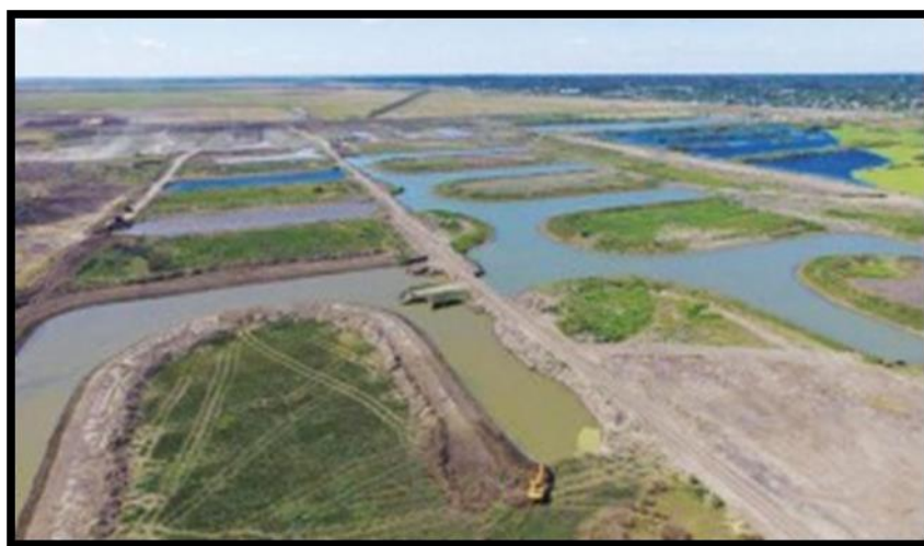
Fig. N°4: Remoción de suelos para construcción de polders, calles internas y lagunas artificiales. Fotografía de Pueblos del Plata.
