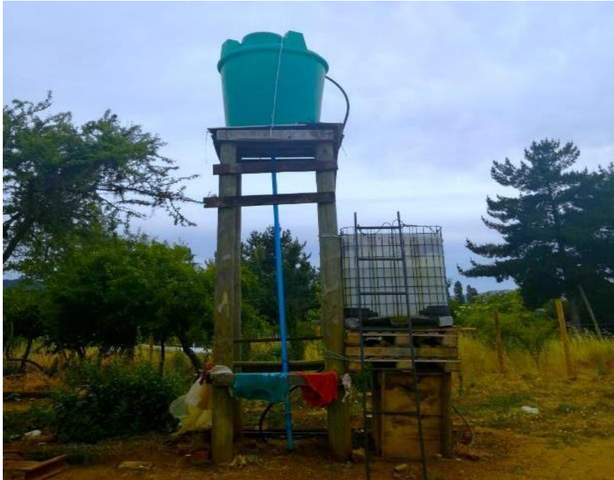
Imagen 1. Pozo agua en provincia Itata
