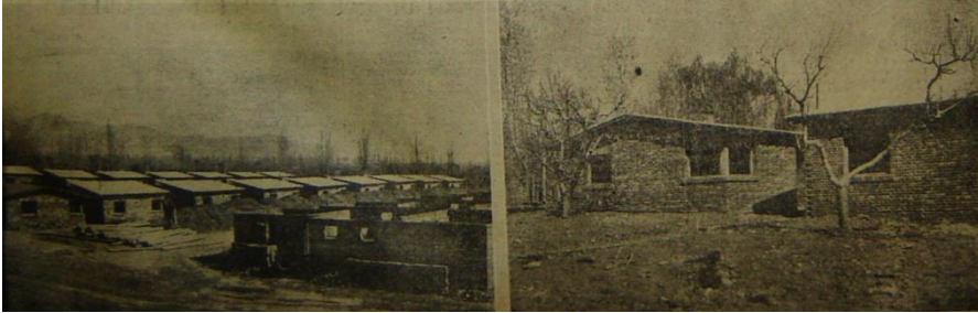
Figura 6: Viviendas del barrio 4 de Junio en construcción.
