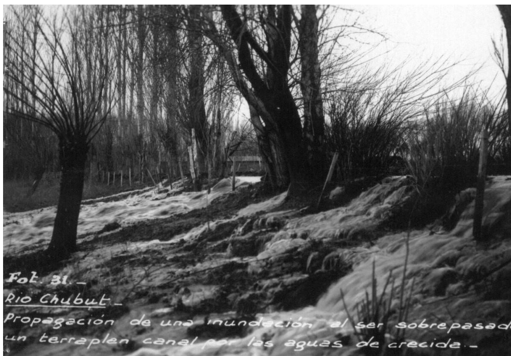
Figura 7: El terraplén de un canal de riego sobrepasado por las aguas de una inundación
