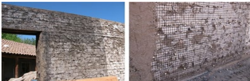
Imagen 7: Geomalla como refuerzo de muros de adobe sismo de 2010
