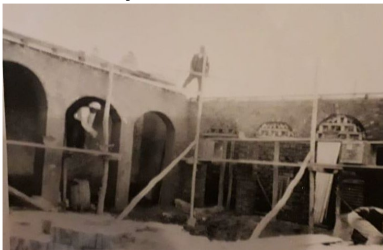
Imagen 11. Construcción de la casa
